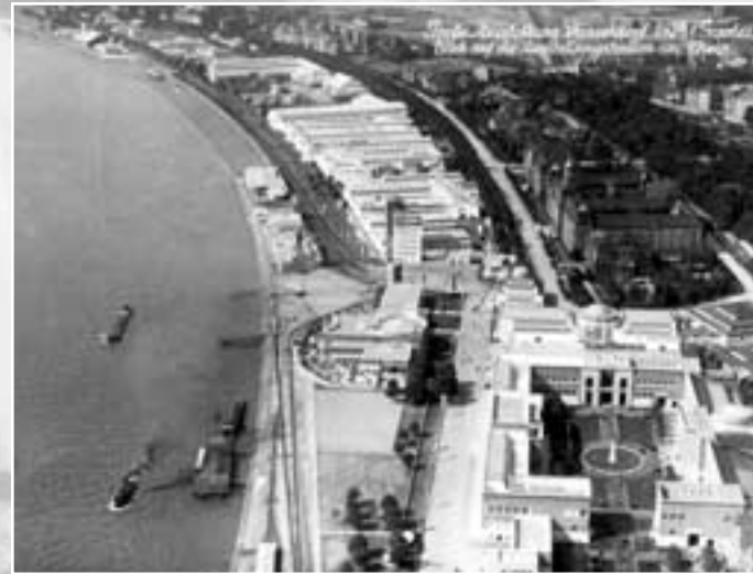
Blick über das Ausstellungsgelände der GeSoLei von 1926.
